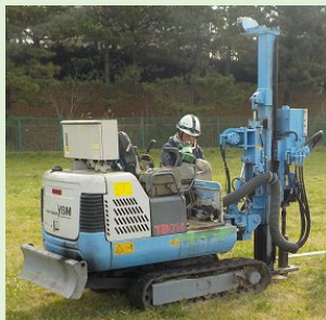
自走式ボーリングマシン によるボーリング調査
