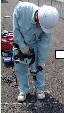
ハンマードリル削孔
