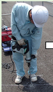
ハンマードリル削孔
