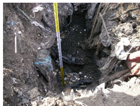
写真 7 埋設廃棄物量の確認状況
